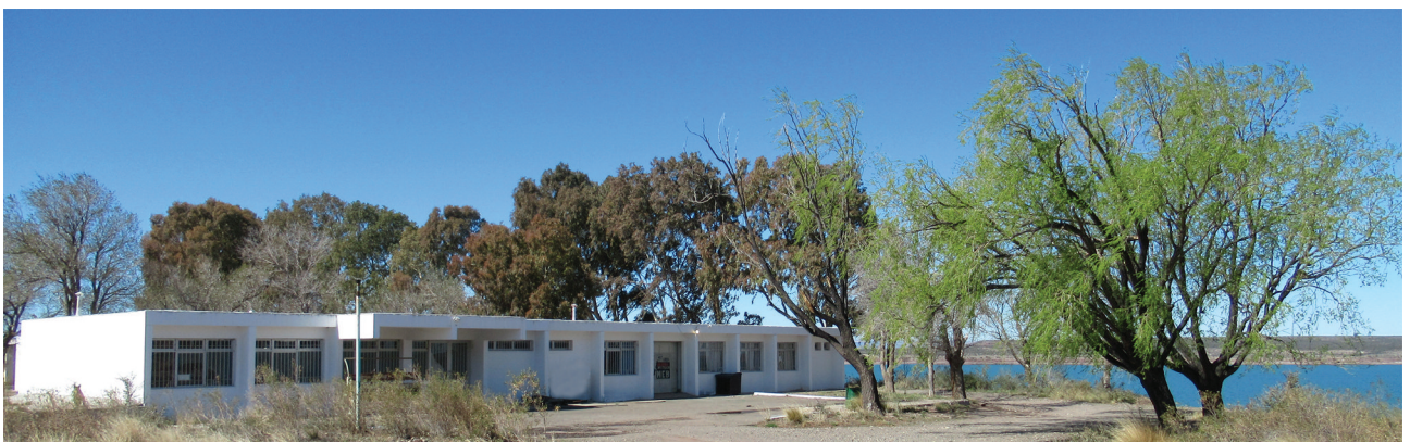
Figura 5. Edificio del Área Laboratorio e Investigación del MEB.
